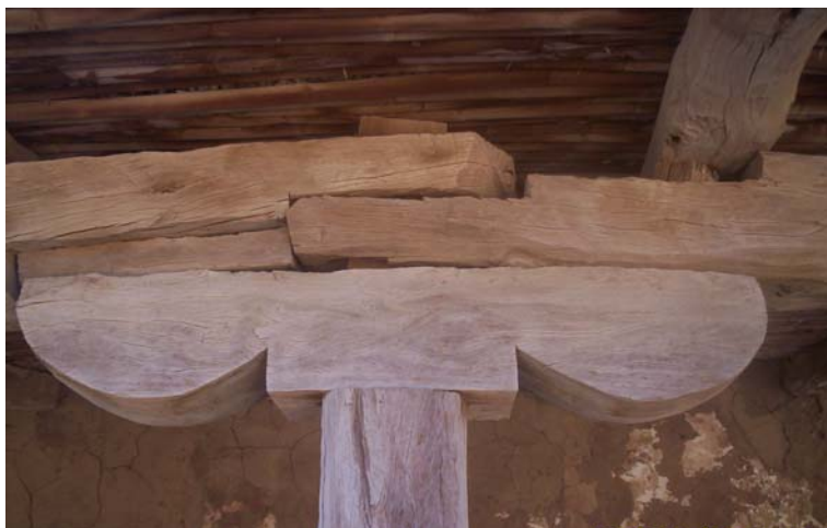
VIGA DE LA CASA DE VICTORIA Y EL CHACHO EN HUAJA
